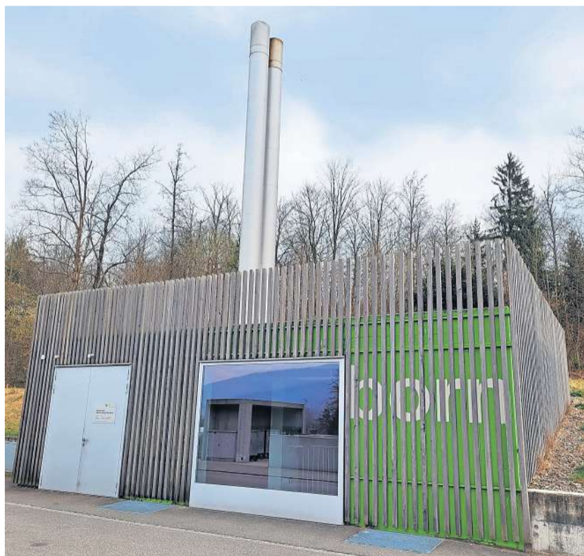
Die Heizzentrale des Wärmeverbunds Bornfeld.
